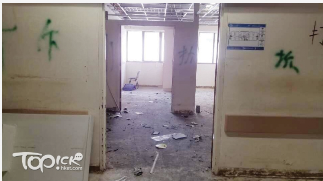
▲ 有關工程範圍已圍封，只有工程人員才能進入。(黃傑偉攝)
